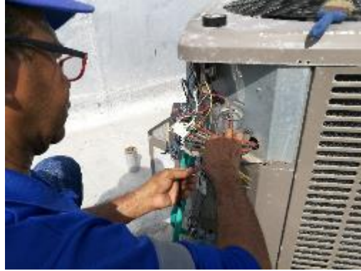
Actividades de mantenimiento preventivo y/o correctivo de equipos de acondicionamiento climático.
